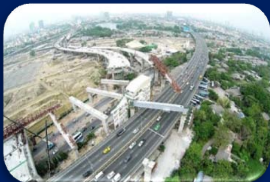
รูปที่ 6. การก่อสร้างทางด่วน
