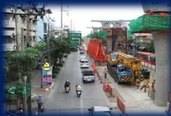
รูปที่ 7. การก่อสร้างทางรถไฟฟ้า
