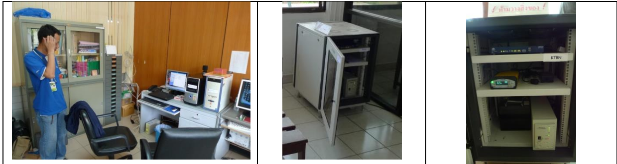
ภาพที่ ๒ - ๖ แสดงอุปกรณ์รับข้อมูลดาวเทียม (Receiver) รุ่น Trimble NetR5 อุปกรณ์เชื่อมต่อ แบบ Router และอุปกรณ์จ่าย/สำรองไฟฟ้า
