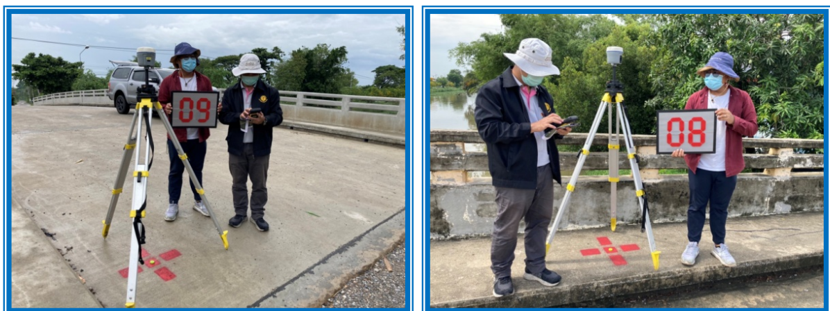
ภาพที่ ๓.๓๘ การสร้างจุดควบคุมภาคพื้นดิน (GCPs)
