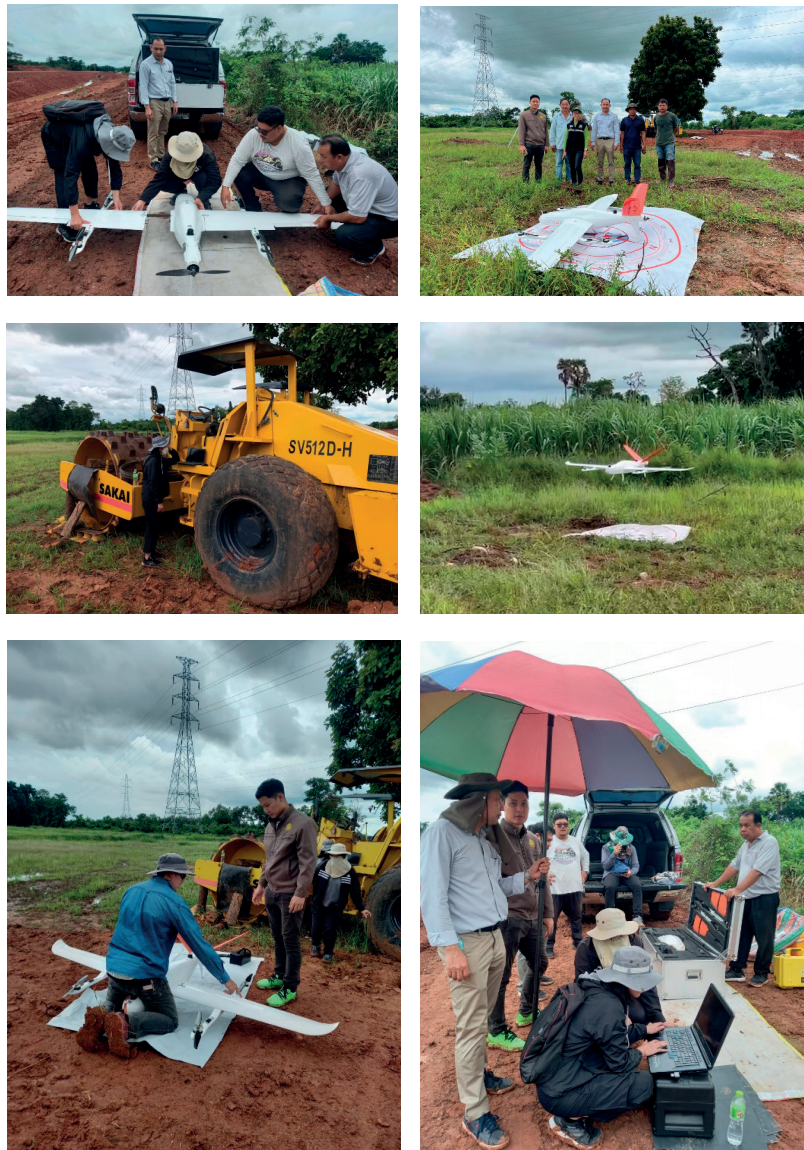
ภาพที่ 3.-1 การบินถ่ายภาพทางอากาศด้วยอากาศยานไร้คนขับ
