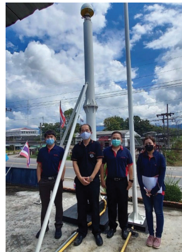
ภาพแสดงการตรวจรับการติดตั้งสถานีรับสัญญาณดาวเทียมอ้างอิง
