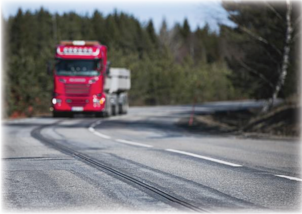
รถบรรทุกไฟฟ้าที่ออกแบบมาเป็นพิเศษกำลังทดสอบระบบชาร์จอัตโนมัติบน “ถนนไฟฟ้า” สายแรกของโลก ประเทศสวีเดน
