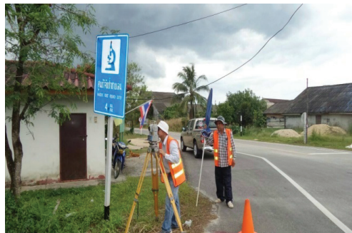
ภาพแสดงการปฏิบัติงานรังวัดวางโครงหมุดหลักฐานแผนที่
