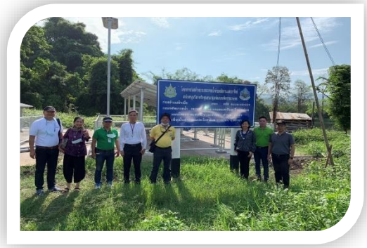
ภาพที่ ๑๑ โครงการส่งน้ำด้วยพลังงานแสงอาทิตย์
