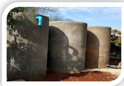
ภาพที่ ๑๔ ถังพักน้ำระหว่างการส่งด้วยพลังงานแสงอาทิตย์
