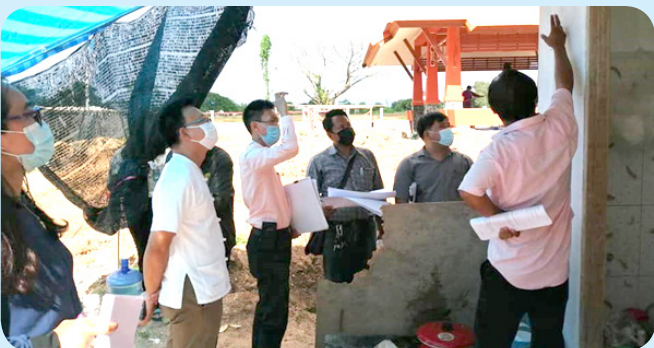
จักรพันธ์ จันทภูมิ จพด.เพชรบูรณ์ พร้อมคณะลงพื้นที่ตรวจติดตามความคืบหน้าการก่อสร้างสำนักงานที่ดินจังหวัดเพชรบูรณ์ สาขาเข็ญบุรี
